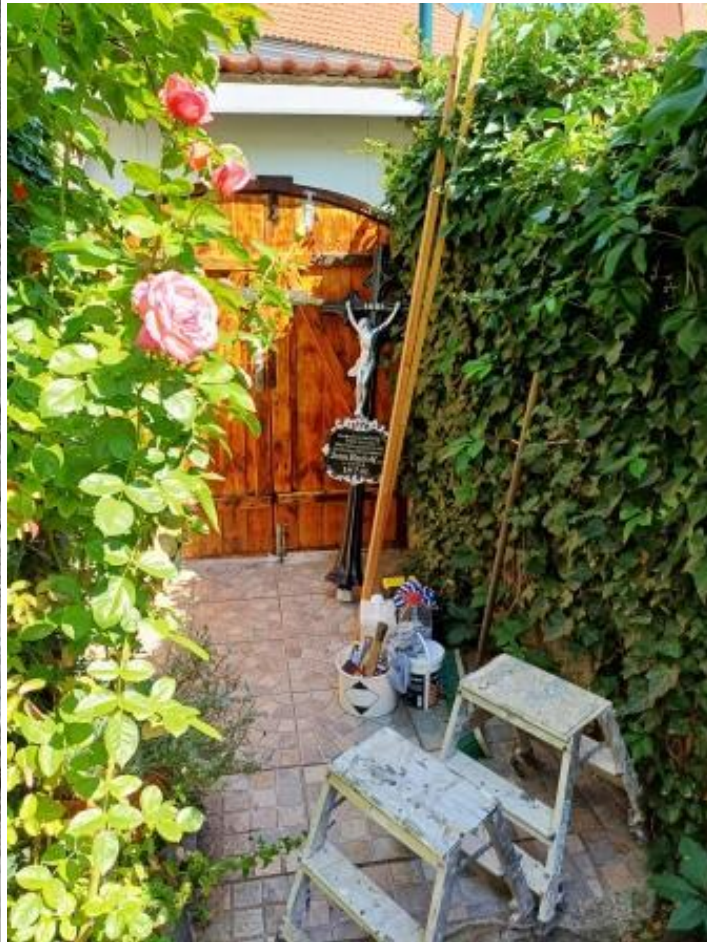
Příprava před instalací
